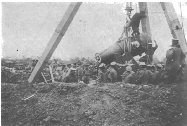
Рис. 20. Установка на позиции японского 280-мм орудия
